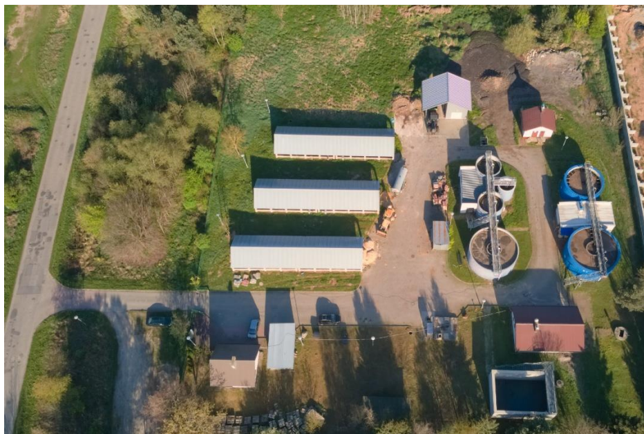
Zdjęcie nr 1. Oczyszczalnia ścieków w Stykowie.
