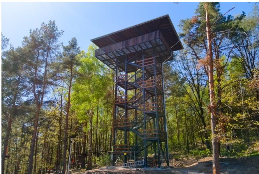
Zdjęcie nr 11. Wieża widokowa przy Centrum Turystycznym.
