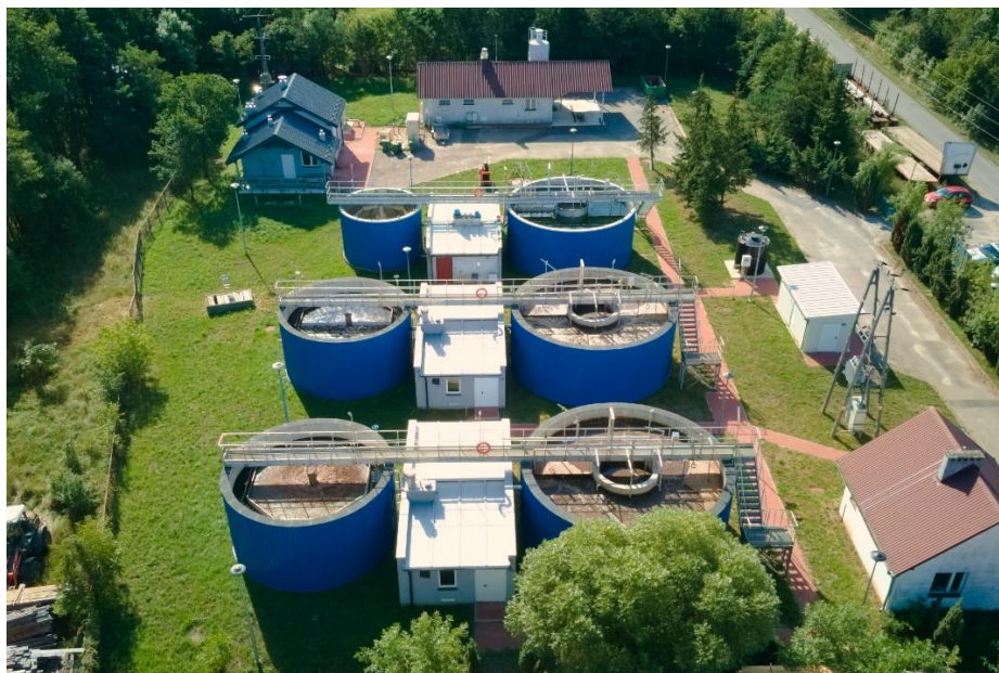
Zdjęcie nr 2. Oczyszczalnia ścieków w Krynkach
