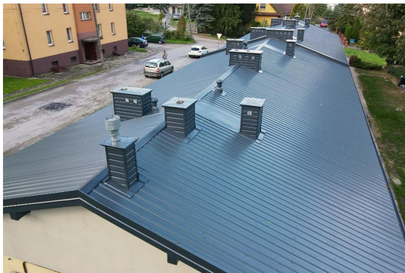
Zdjęcie nr 6. Nowy dach na budynku komunalnym.
