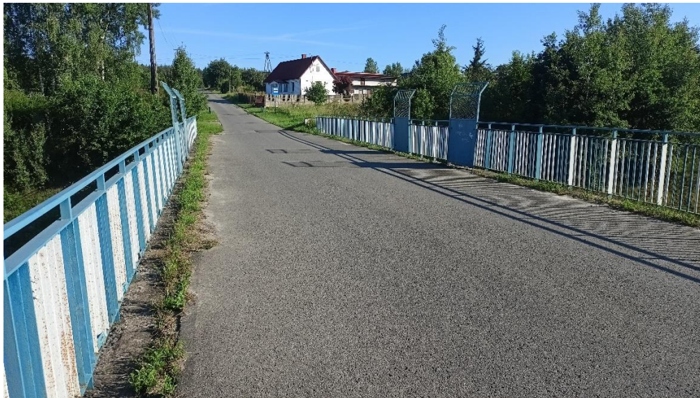
Zdjęcie nr 12. Wiadukt nad torami w miejscowości Ruda.
