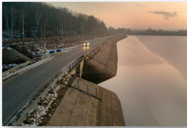
Zdjęcie nr 26. Droga między miejscowościami Brody i Ruda – gdzie planowana jest budowa ciągu pieszo-jezdnego
