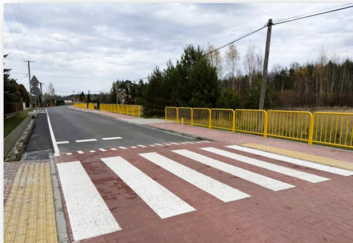
Zdjęcie nr 36. Adamów ul. Szkolna - po zakończeniu prac
