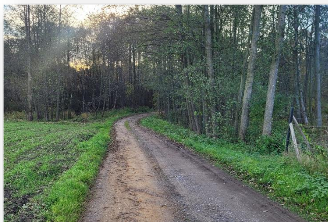
Zdjęcie nr 37. Droga przez wieś Kuczów - przed wykonaniem prac
