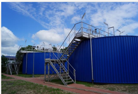
Zdjęcie nr 25. Oczyszczalnia Ścieków w Krynkach
