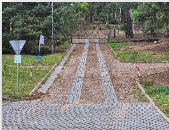
Zdjęcie nr 17. Zmodernizowana droga dojazdowa do pola kempingowego przy Centrum Turystycznym
