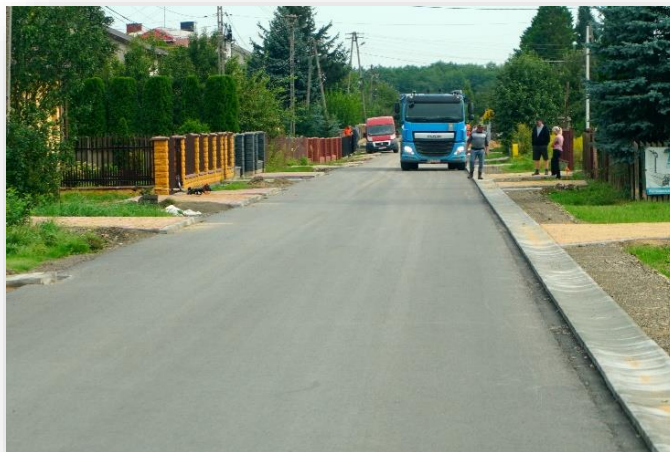
Zdjęcie nr 34. Lipie, ul. Starachowicka - po zakończeniu prac
