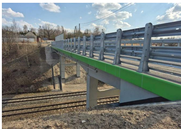
Zdjęcie nr 30. Zmodernizowany wiadukt
