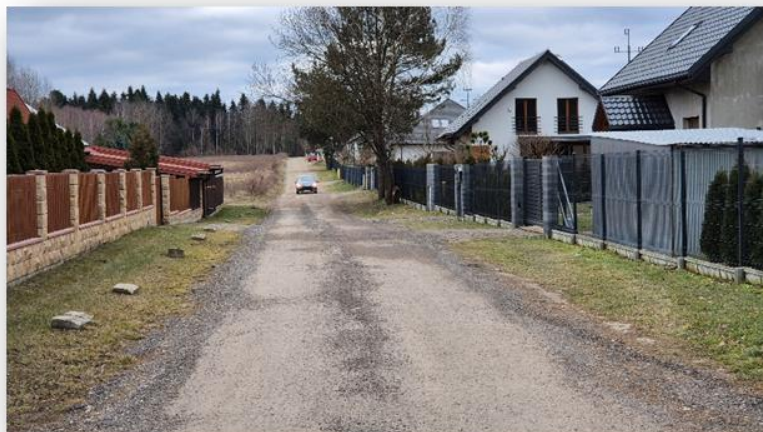
Zdjęcie nr 6. ul. Słoneczna w m. Lipie – przed rozpoczęciem prac
