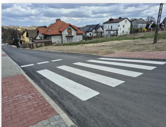
Zdjęcie nr 23. Ul. Apteczna w Krynkach po wykonaniu prac
