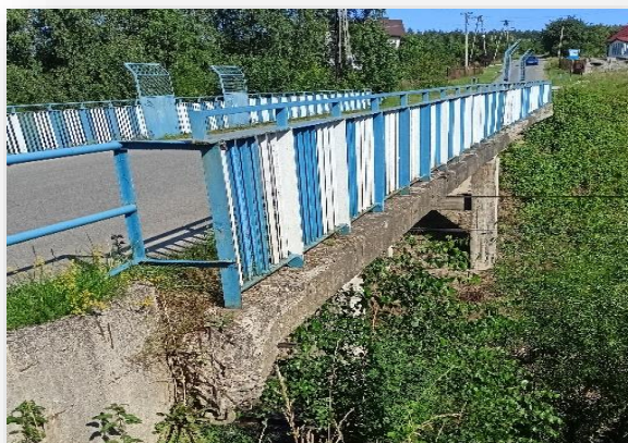
Zdjęcie nr 29. Wiadukt w Rudzie przed wykonaniem prac
